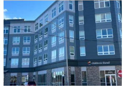
Parcel 9 Phase 1 Complete
